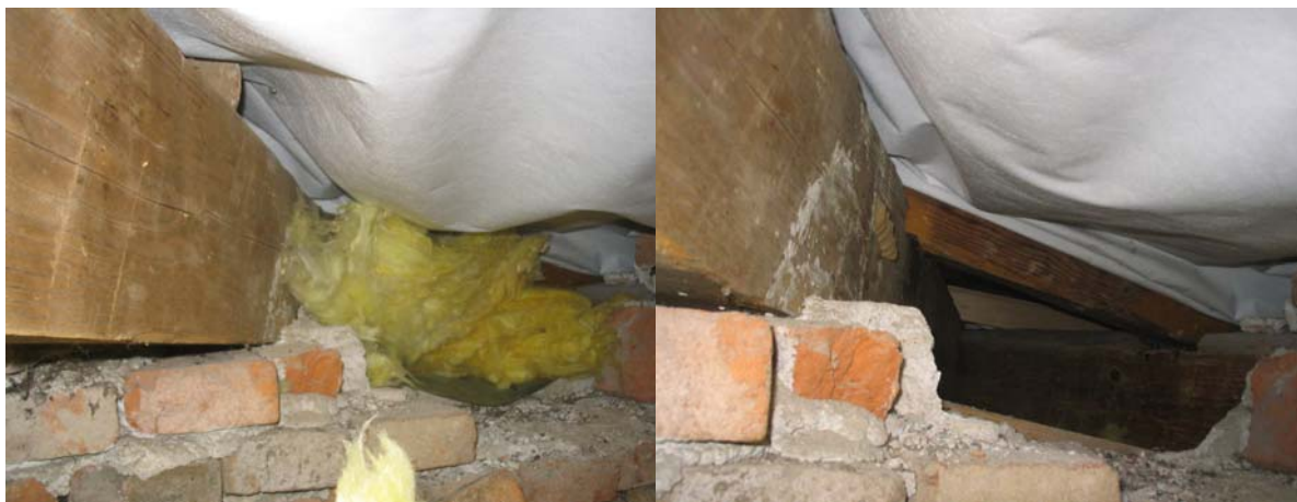
Slika 6. Prehod med podstreho severovzhodnega trakta in skrivališčem za puške ob vzhodnem stolpu grada Snežnik pred in po odstranitvi izolacijske volne. (foto: P. Presetnik; 11.6.2008)
